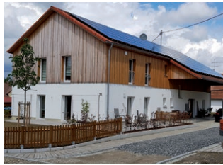
Ehemalige Hofstelle in Jedesheim nach dem Umbau (2021)
